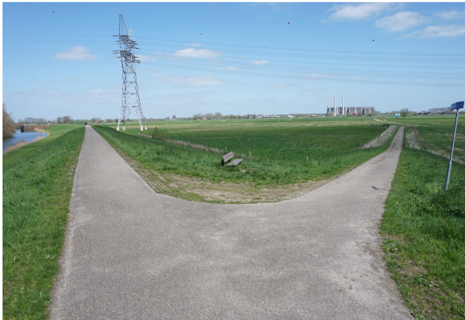
Fietspad op de dijk en insteekweg in uiterwaard bij keersluis Bastion
