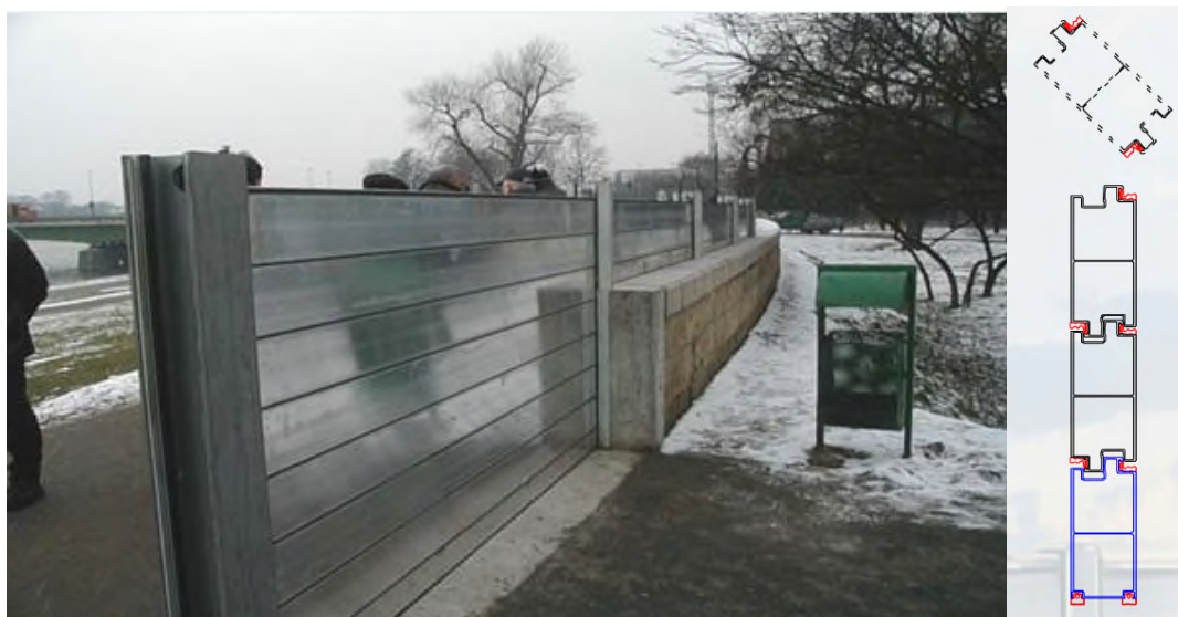
Figuur 3 Links: Coupure met DPS2000 en rechts: speciale vertanding schotbalken.
