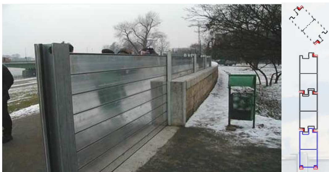
Figuur 2 Links: Coupure met DPS2000 en rechts: speciale vertanding schotbalken.
