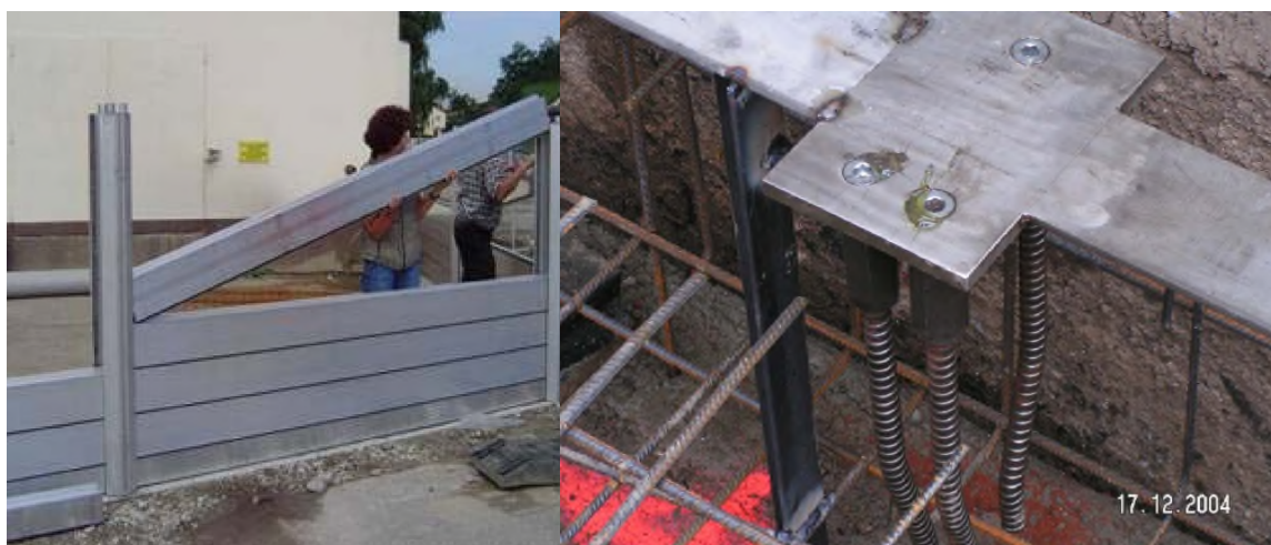
Figuur 4 Links: opbouwen systeemwand en rechts: ankerplaat standers
