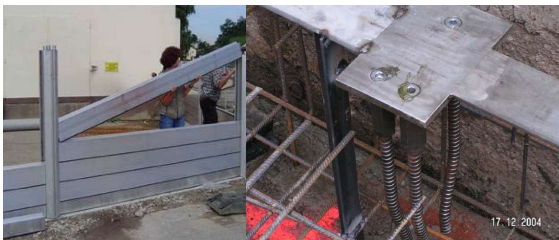
Figuur 3 Links: opbouwen systeemwand en rechts: ankersplaat staanders
