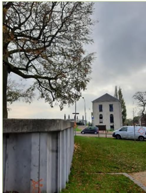
De damwand staat op de rand van de kroonprojectie van de boom.
