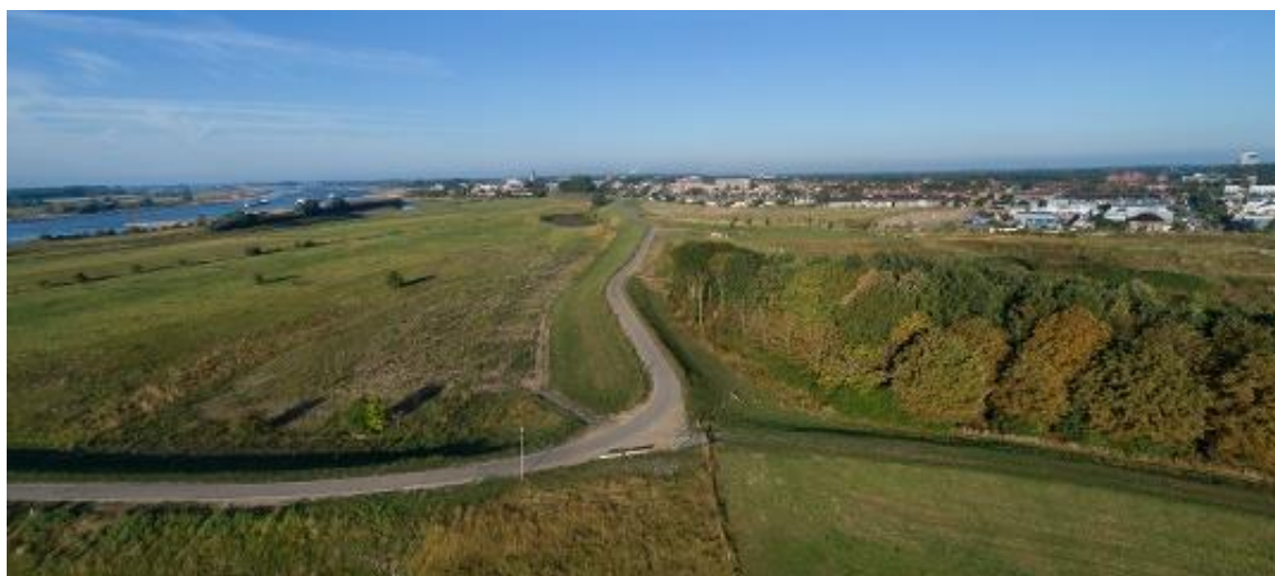
Figuur 2.3 'Klimaatdijk' Fluvia Tiel (bron: WSRL)
