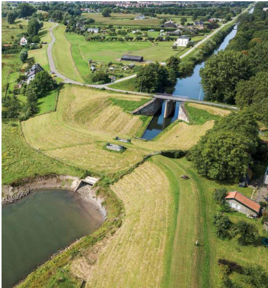
Figuur 2.9 Inundatiekanaal en inlaatduiker (bron: HNS)
