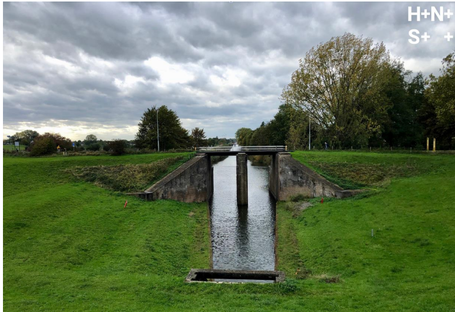
Figuur 3.8 Zicht op de voormalige sluis en het inundatiekanaal, vanaf de kruin van de dijk boven de duiker.
