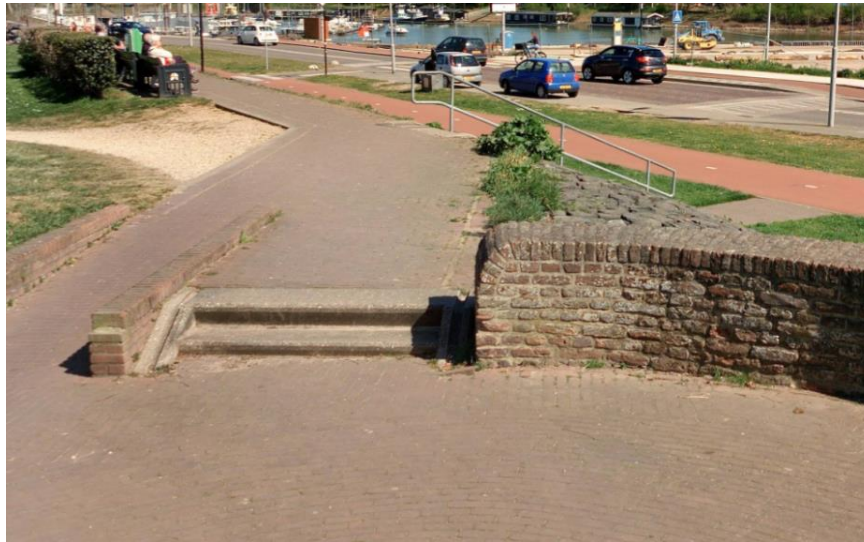
Figuur 4.5 Huidige aansluiting van de vestingmuur Tolhuiswal op de waterkering van deeltraject 4A-3.
