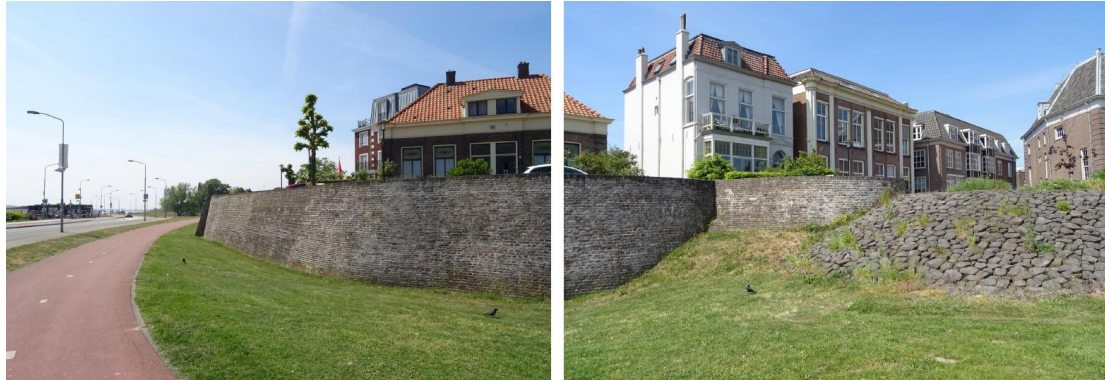
Figuur 4.3 Huidige overgang vanaf de basaltmuur (rechts) naar de historische vestingwal (links).
