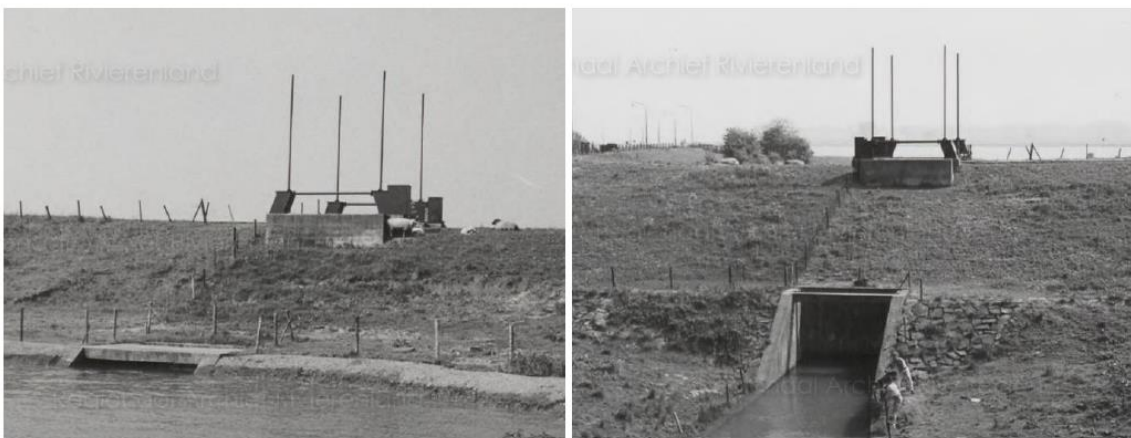
Buiten- en binnenaanzicht van de nieuwe inlaatsluis, foto circa 1985 (Bron: Regionaal Archief Rivierenland, M3482 en M3484).
