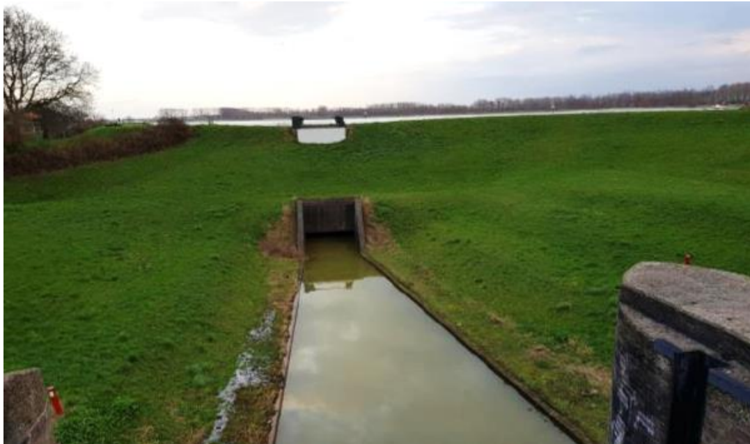
Figuur 4.37 Zicht op de dijk: huidige situatie gezien vanaf de weg op de voormalige sluis.
