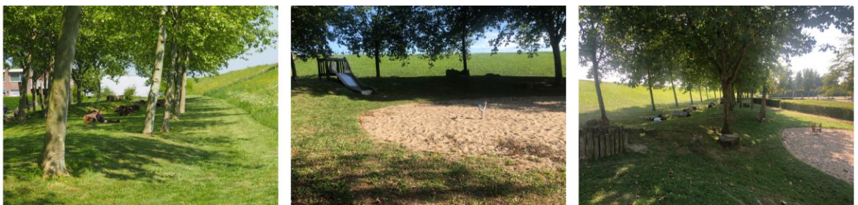
Figuur 5.5. Huidige situatie binnendijks in deeltraject 5B. Hier wordt een berm en leeflaag aangebracht. Recreatieve functies worden daarna teruggebracht in samenwerking met de gemeente Tiel.
