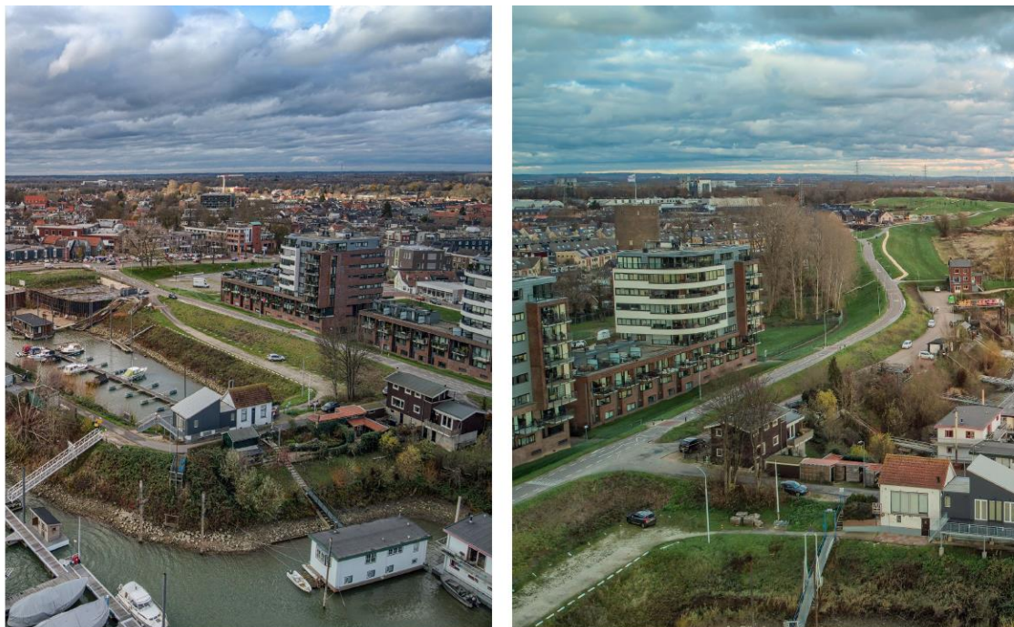
Figuur 4.5 Deeltraject 3A: Haven (Echteldsedijk). Links: westzijde met aansluiting op deeltraject 3B. Rechts: oostzijde met aansluiting op Fluvia Tiel.
