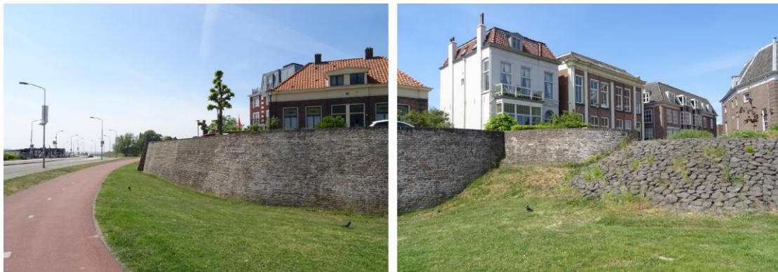
Figuur 5.2 Huidige situatie: overgang van deeltraject 4A-3 (basalt) naar de historische Vestingmuur Tolhuiswal
