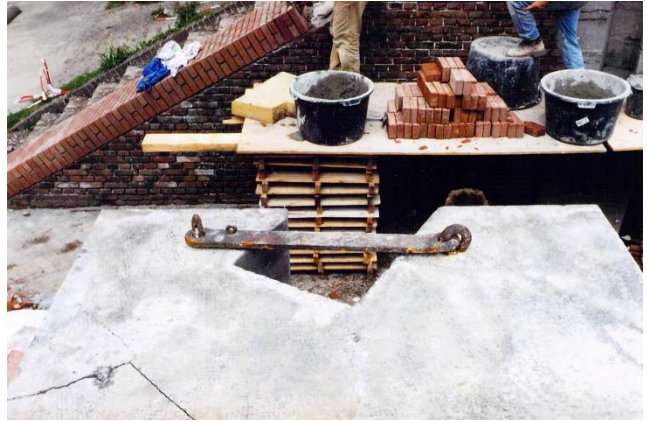
Figuur 10-11 Scheuren in natuurstenen sponning (links en rechts) en aanbrengen metselwerk rollaag zuidelijke wand (rechts), Jack Buis, 1996-1997
