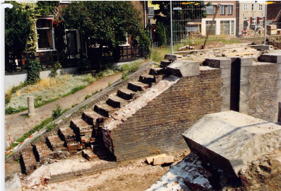
Figuur 10-9 Renovatie noordelijke wand en trap, Jack Buis, 1996-1997
