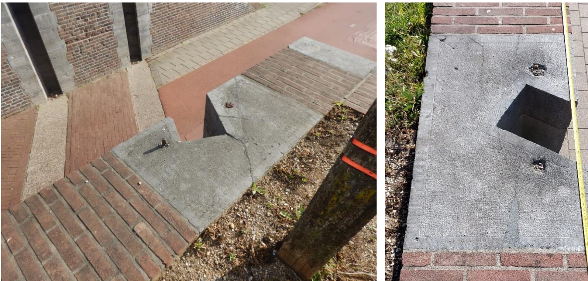
Figuur 7-1 Buitendijkse sponning zuidelijke wand (links) en noordelijke wand (rechts)
