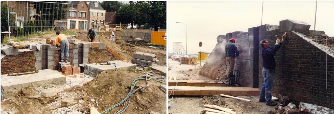
Figuur 10-10 Aanbrengen metselwerk rollaag noordelijke wand (links) en vernieuwen voegwerk zuidelijke wand (rechts), Jack Buis, 1996-1997
