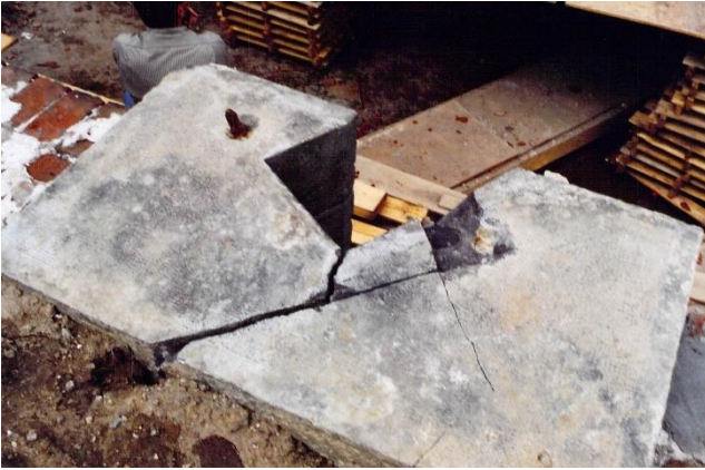
Figuur 10-11 Scheuren in natuurstenen sponning (links en rechts) en aanbrengen metselwerk rollaag zuidelijke wand (rechts), Jack Buis, 1996-1997
