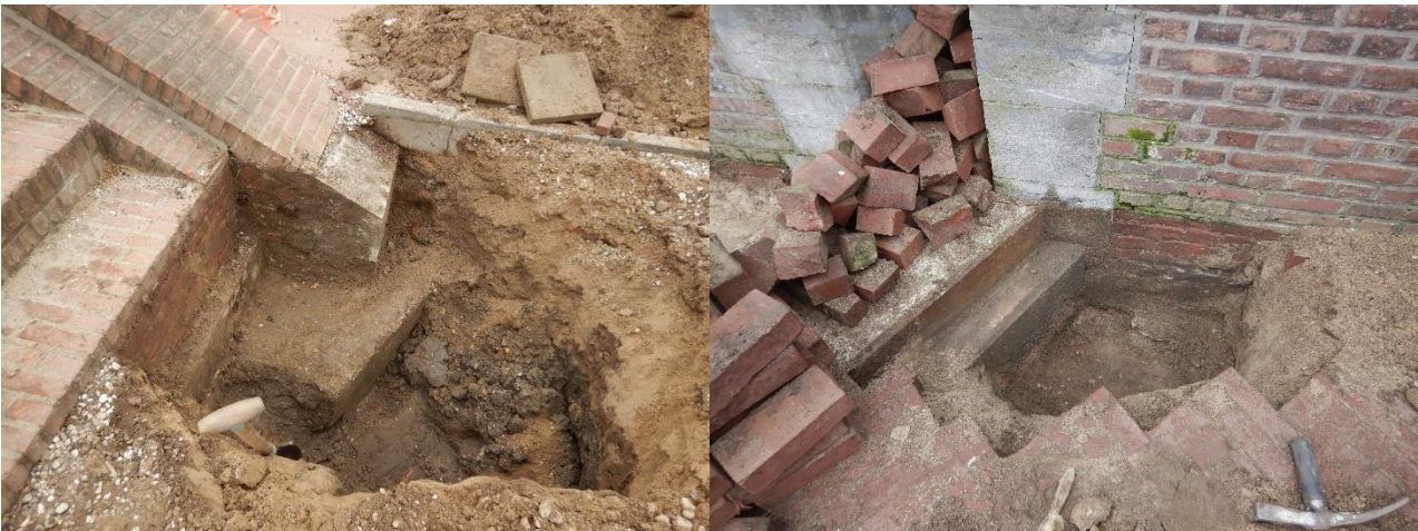
Figuur 10-16 Betonnen funderingsplaat t.p.v. zuidelijke wand buitendijkse zijde (links; zie [11]) en onderlagbalk sponning zuidelijke wand binnendijkse zijde (rechts; zie [11])
