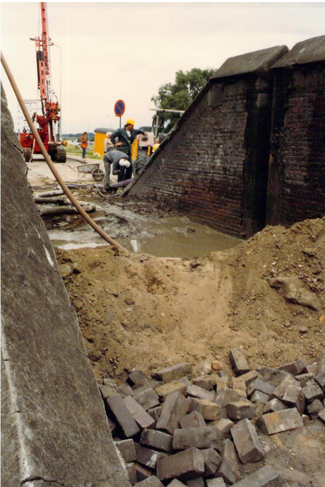
Figuur 10-12 Aanbrengen jetgroutkolommen (links) en volledige sloop zuidelijke trap buitendijks (rechts), Jack Buis, 1996-1997
