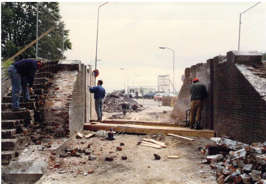
Figuur 10-8 Renovatie wanden en noordelijke trap, Jack Buis, 1996-1997
