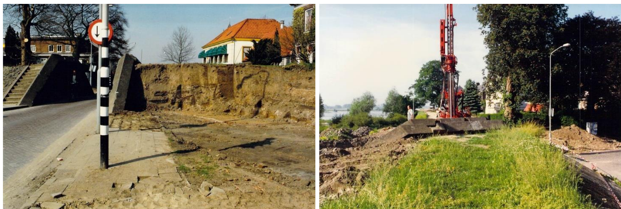
Figuur 10-6 Ontgraving noordelijke wand (links) en aanbrengen jetgroutkolommen achter zuidelijke wand (rechts), Jack Buis, 1996-1997
