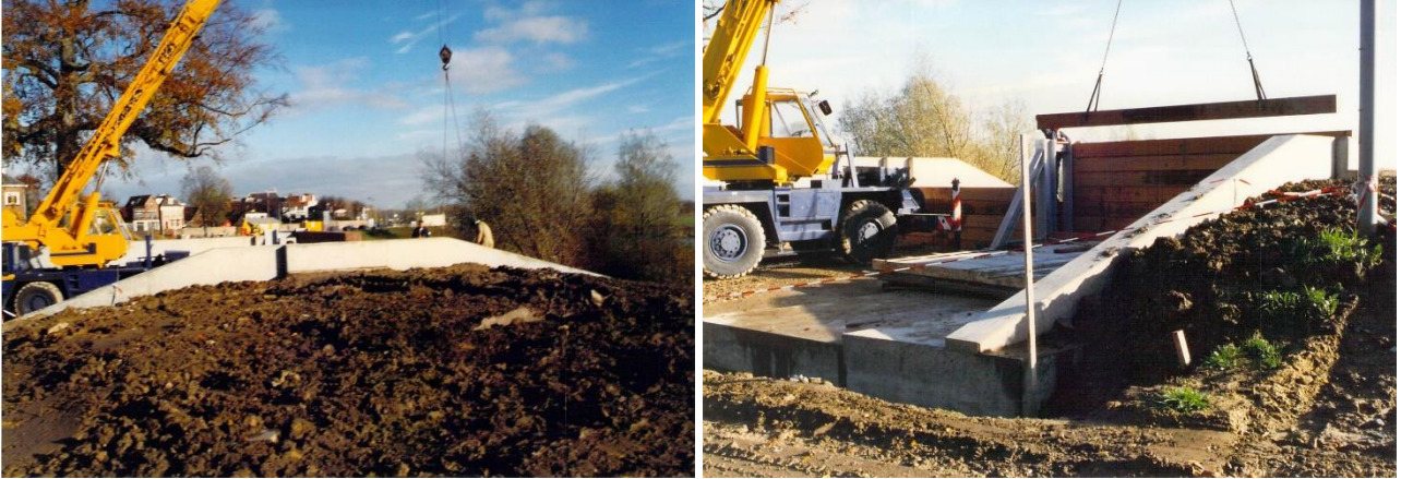
Figuur 10-3 Proefsluiting na aanleg coupure Bellevue, Jack Buis, 1996-1997
