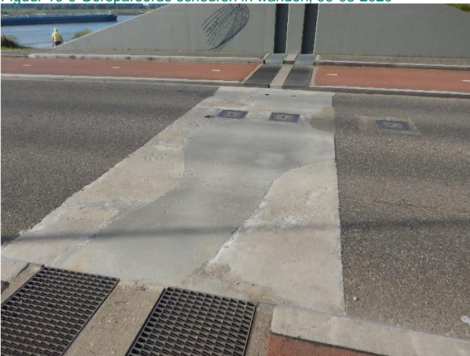
Figuur 10-10 Gerepareerde schotbalkspinning in vloer rijweg, 06-08-2020
