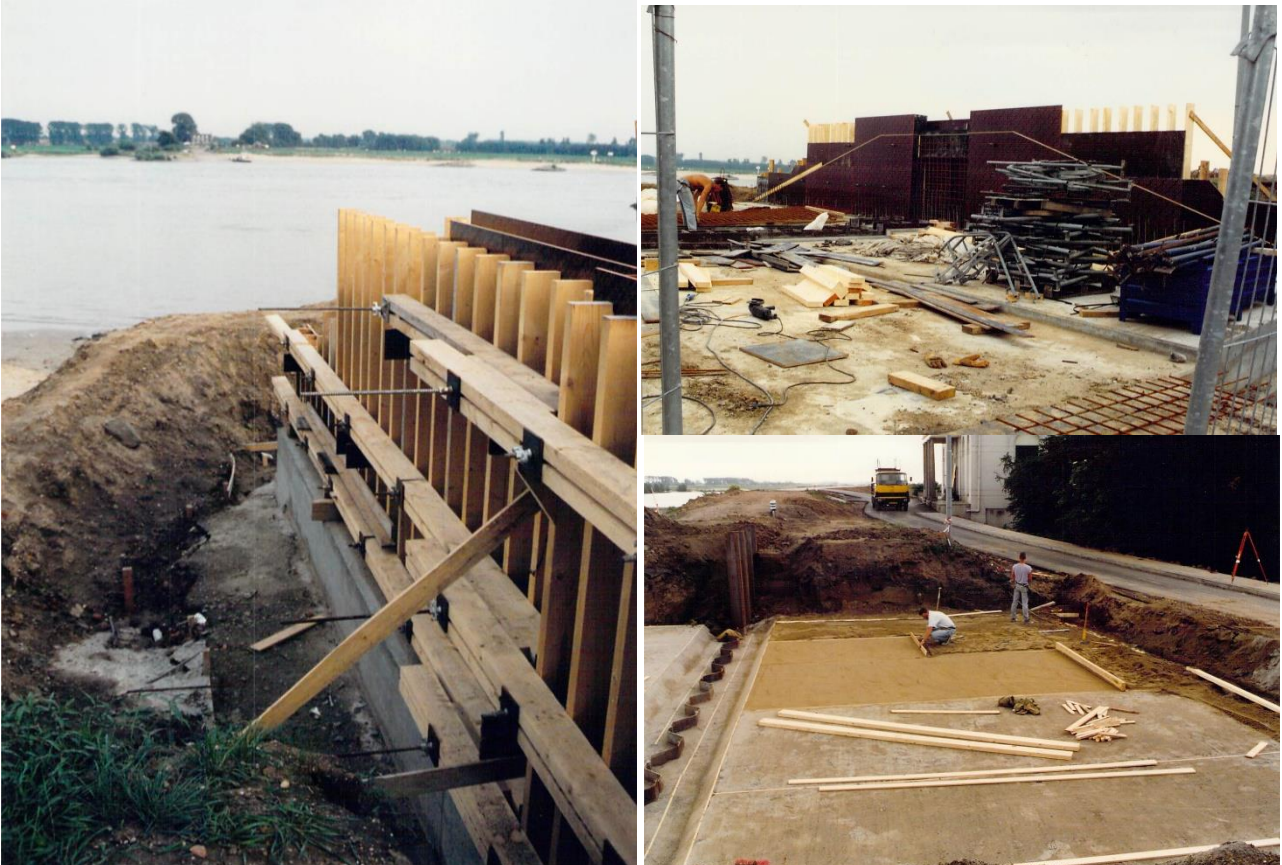
Figuur 10-2 Aanleg coupure Bellevue vlak naast de Waal (links), bekisting zuidelijke wand (rechtsboven) en egalisatie zandbed t.b.v. werkvloer (rechtsonder), Jack Buis, 1996-1997
