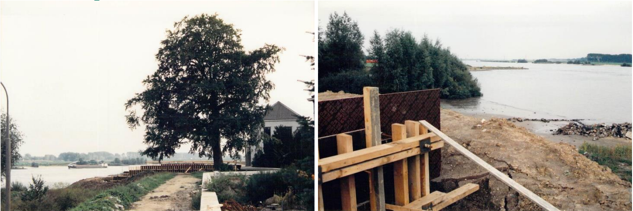
Figuur 10-1 Aanleg coupure Bellevue vlak naast de Waal, Jack Buis, 1996-1997
