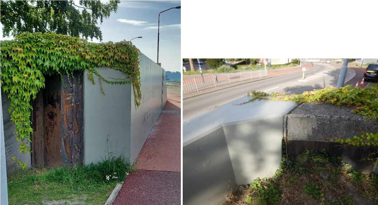
Figuur 10-5 Aansluiting noordelijke wand op damwandscherm Ravelijn vanaf buitenzijde (links) en bovenzijde (rechts), 06-08-2020
