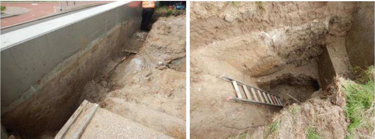
Figuur 2-8 Werkvloer onder vleugelwand (zie [6])
