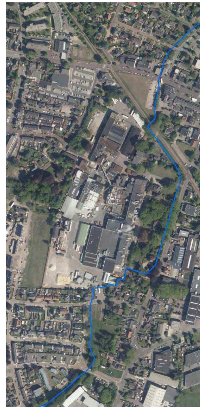
Beekligging in plangebied, Bekenstichting
