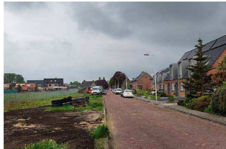
Wegbeeld Poelkampstraat en nieuwbouw woningen
