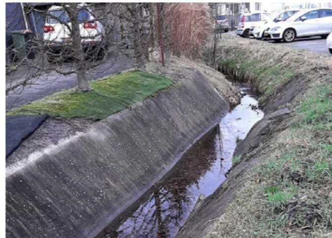
Eerbeekse beek in betonstortbed aan entreezijde [REDACTED] Eerbeek
