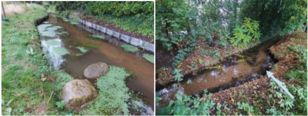
Figuur 6.1: Voorbeeld van opstuwing en afwisseling in stroomsnelheid door het aanbrengen van stenen in de beek (links) en het lokaal verbreden van de beek (rechts).
