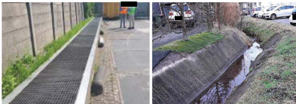
Figuur 1.3: De Eerbeekse beek op het terrein van de papierfabriek (links: overkluisd en rechts: in beton). Bron: Ecogroen (2020).
