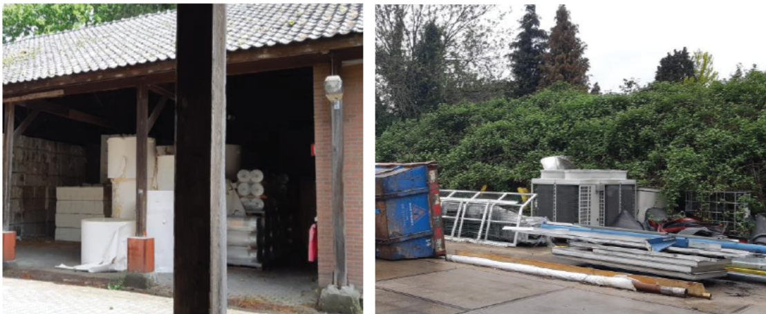
Figuur 4.3 Potentiële verblijfplaatsen van steenmarter in bebouwing en puinhopen binnen het plangebied. Foto's: Ecogroen.
